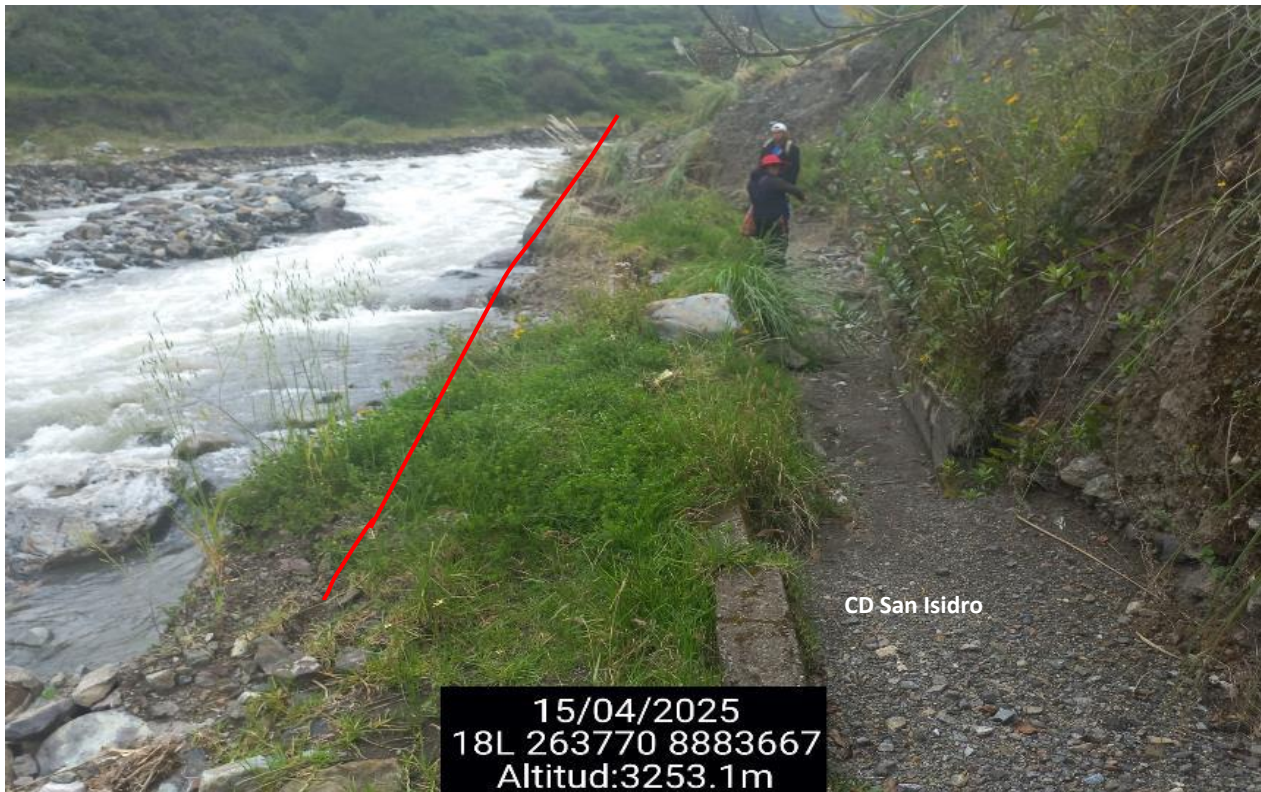
FIGURA N°03: VISTA AGUAS ARRIBA, EN LA MRGEN IZQUIERDA SE OBSERVA EL CANAL CD SAN ISIDRO, CUYO CAPTACION FUE ARRASADA POR EL RIO.
